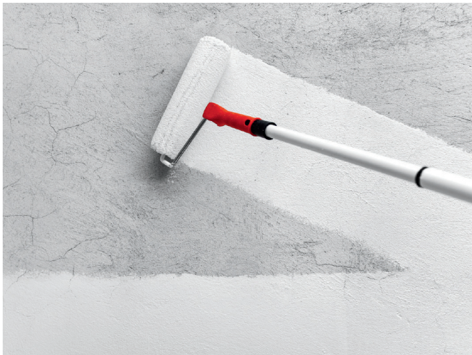
APPLICATION OF PRIMER COAT
